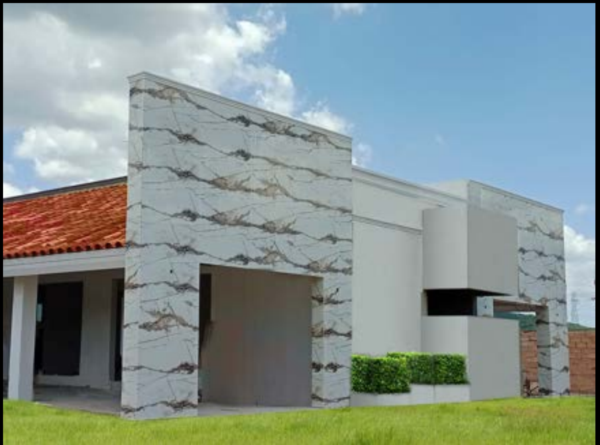
Casa Habitación Culiacán, Sin
