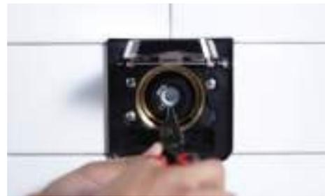
TruFlush fue diseñado con la menor cantidad de piezas posibles, haciendo que su mantenimiento sea muy sencillo. Se accede fácilmente a las piezas a través de la placa de pared y están diseñadas para minimizar la posibilidad de fugas.
